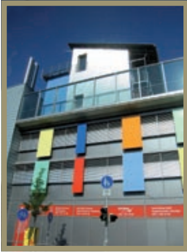
La 'Solar Haus' à Freiburg produit plus d'énergie qu'elle n'en consomme. Au-dessus des bureaux, sur la toiture, on observe des maisons unifamiliales et leur jardin. © carnotzet, flickr.com
