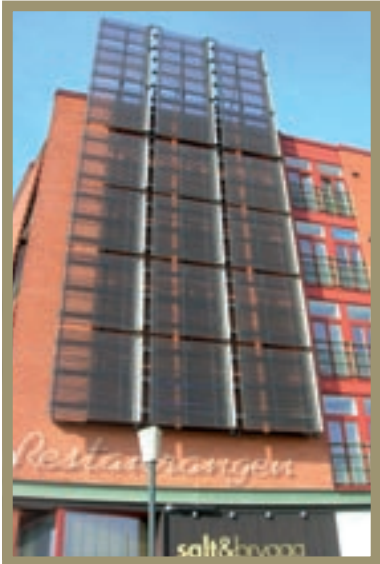
Cet édifice à Malmö est revêtu de panneaux solaires pour le chauffage de l'eau.
