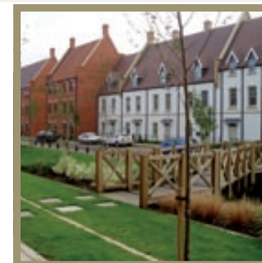
Upton en Angleterre est sillonné d'oueds. Il s'agit de bassins de végétation qui peuvent recueillir l'eau de pluie surabondante. En période sèche, ils peuvent servir de terrain de jeu. © Tcpa
