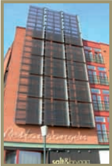
Dit gebouw in Malmö is versierd met panelen voor zonneboilers.
